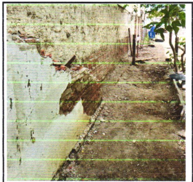
FOTO - 06 DEMOLIÇÃO DE ALVENARIA DE BLOCO FURADO, DE FORMA MANUAL, SEM REAPROVEITAMENTO. AF_09/2023
