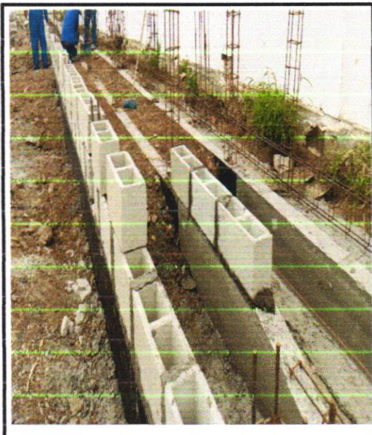
FOTO - 19 Muro em alvenaria bloco
