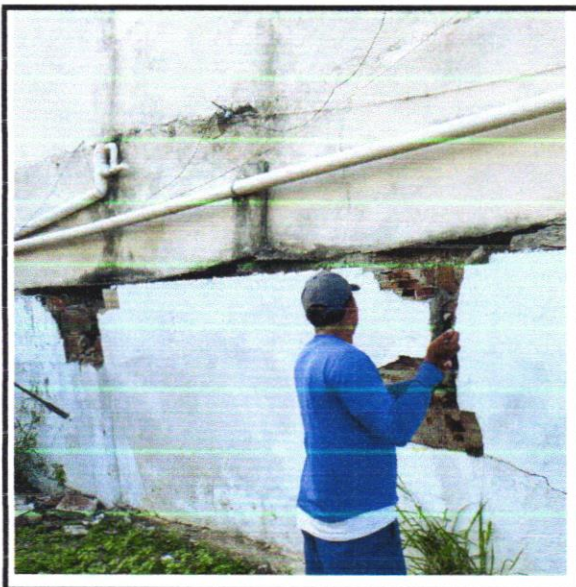
FOTO - 05 DEMOLIÇÃO DE ALVENARIA DE BLOCO FURADO, DE FORMA MANUAL, SEM REAPROVEITAMENTO. AF_09/2023
