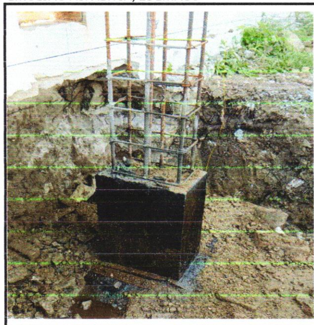
FOTO- 24 IMPERMEABILIZAÇÃO DE SUPERFÍCIE COM EMULSÃO ASFÁLTICA, 2DEMÃOS
