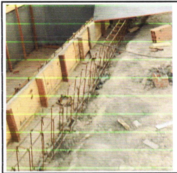
FOTO 16-ARMAÇÃO DE PILAR OU VIGA DE UMA ESTRUTURA CONVENCIONAL DE CONCRETO ARMADO EM UMA EDIFICAÇÃO TÉRREA OU SOBRADO UTILIZANDO AÇO CA-50 DE 8,0 M
