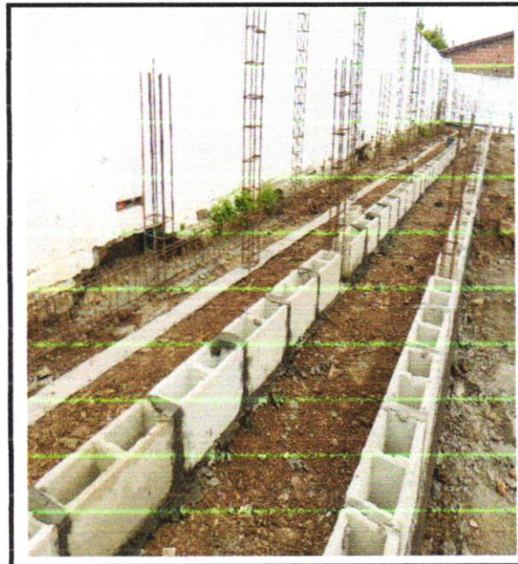
FOTO- 20 Muro em alvenaria bloco
